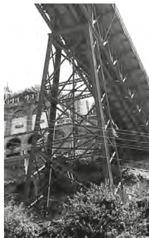
Pilar metálico n.º 1 situado em Gaia, vista geral detalhes e esquema tipo “Pilar PP” entre o tabuleiro superior e o arco
