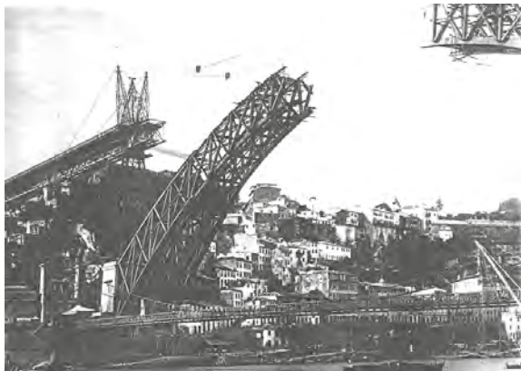
Fase construtiva da Ponte Luiz I, impondo-se à Ponte Pênsil
