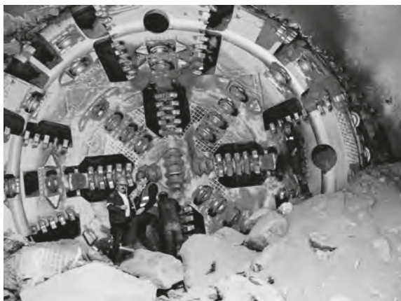
Tuneladora à chegada a S. Bento
