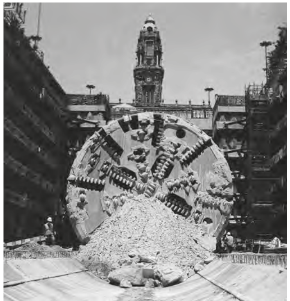
Registo de uma cartografia geológica expedita na frente da tuneladora Tuneladora após chegada à estação Aliados
