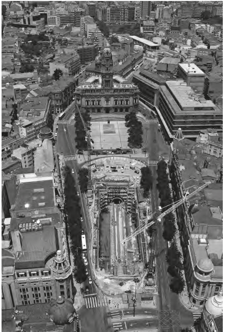
Estação Aliados – Toda a escavação executada em cut & cover
