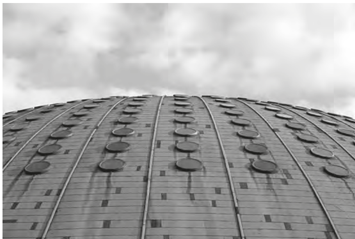
Fotografia da cobertura na atualidade.
