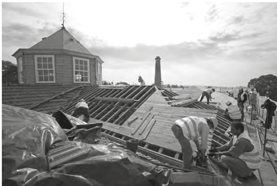
Fig. 19. Desvão do telhado durante o tratamento (antes da aplicação do isolamento térmico sobre o plano horizontal); Aplicação do forro de madeira ventilado para suporte do complemento de estanquidade permeável ao vapor.
