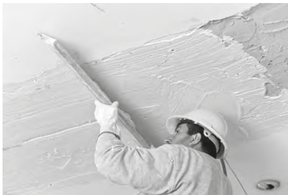
Fig 18. Grande espessura das paredes existentes exteriores e interiores e aplicação de revestimentos à base de cal.
