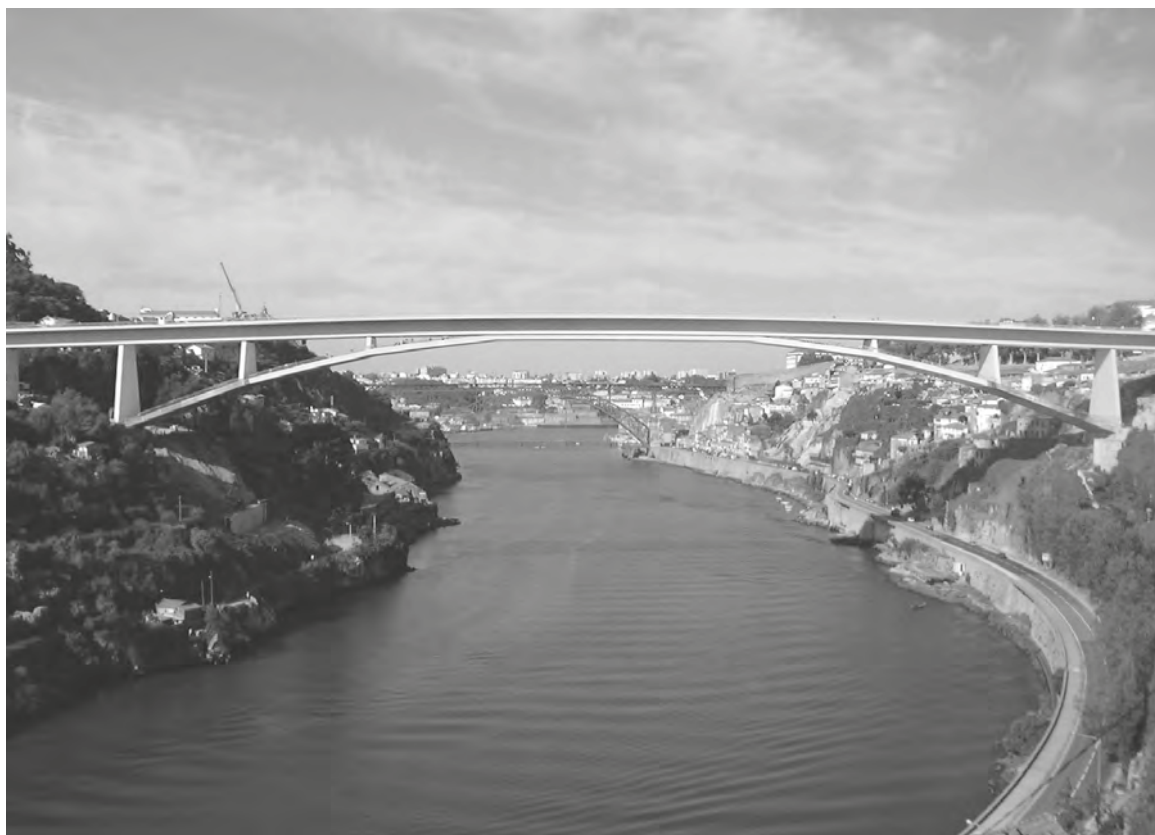
Fig. 1. Alçado da Ponte em final de construção.
