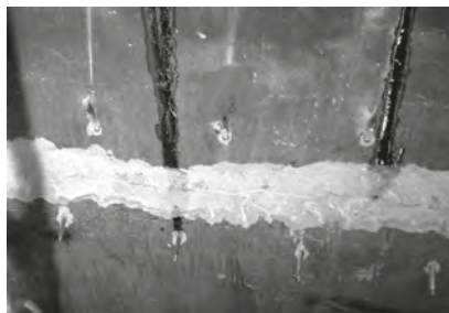
Injeção de resinas
