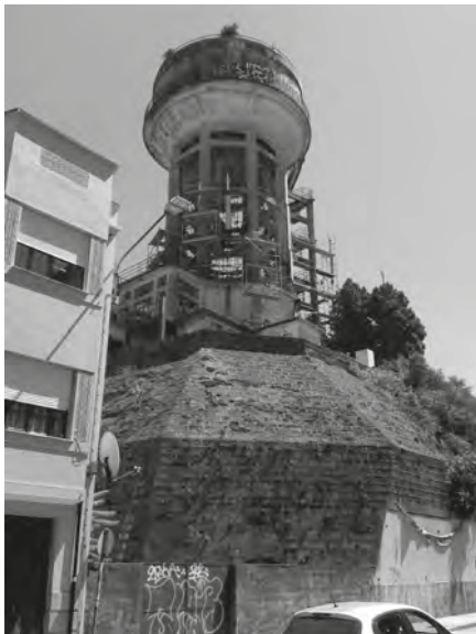
Torre de Pressão antes da reabilitação
