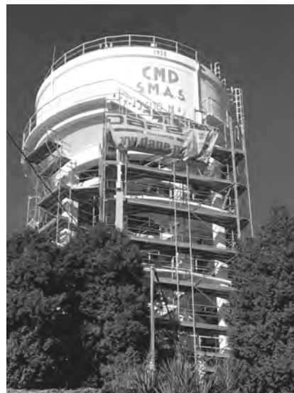
Torre de Pressão em fase final de reabilitação, 2018
