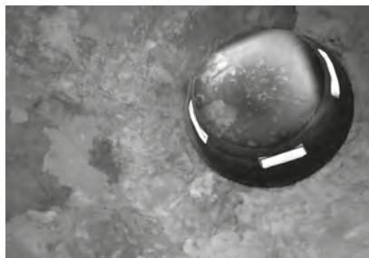
Aplicação de revestimento epoxico
