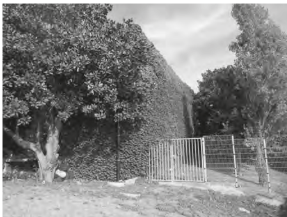
Fig. 26. Vista dos reservatórios inferiores do Corpo A. Atente-se ao aspeto excelente do betão 15 anos após o início da exploração.
