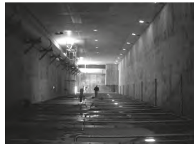
arranque de parede interior com os cordões de pré-esforço já ancorados na face inferior e enrolados para posterior posicionamento na vertical.
