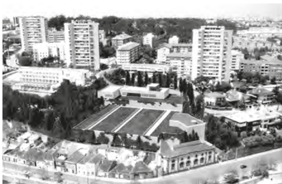
Fig. 4. Vista aérea do edifício da ETAR de Sobreiras, inserida numa zona habitacional, cercada de árvores e com cobertura ajardinada.
