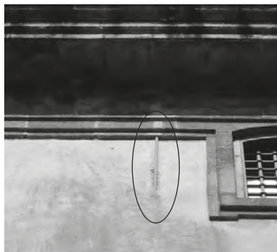
Fig. 60 Esmagamento do reboco nas amarrações dos tirantes T6 e T7 na parede da fachada lateral direita.
