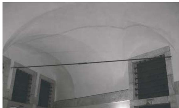
Fig. 58 Tirantes metálicos no interior do edifício.
