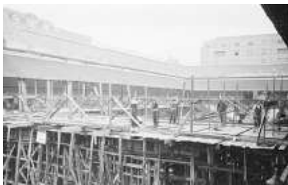
Fig. 51. Obras da Passagem 1938 (AHMP).
