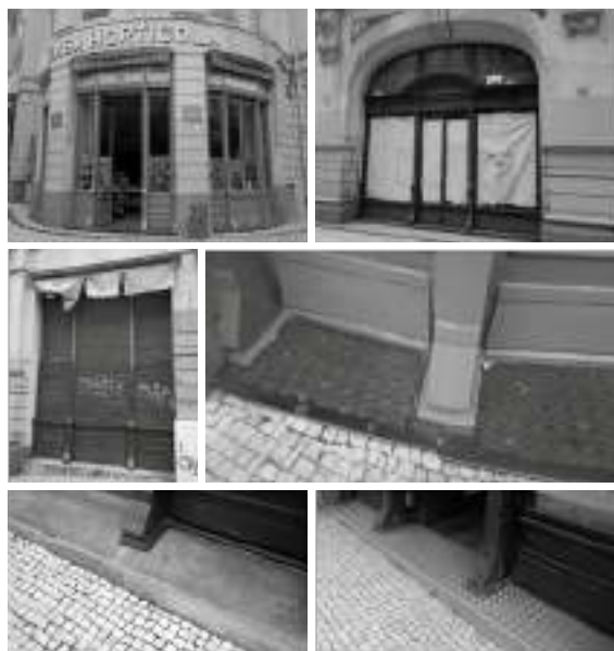
Fig. 25. Valores e "não-valores": caixilharia original em ferro fundido, soleiras originais e adulteradas.
