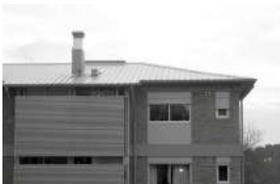
Fig. 15. Intervenção nos vãos exteriores
