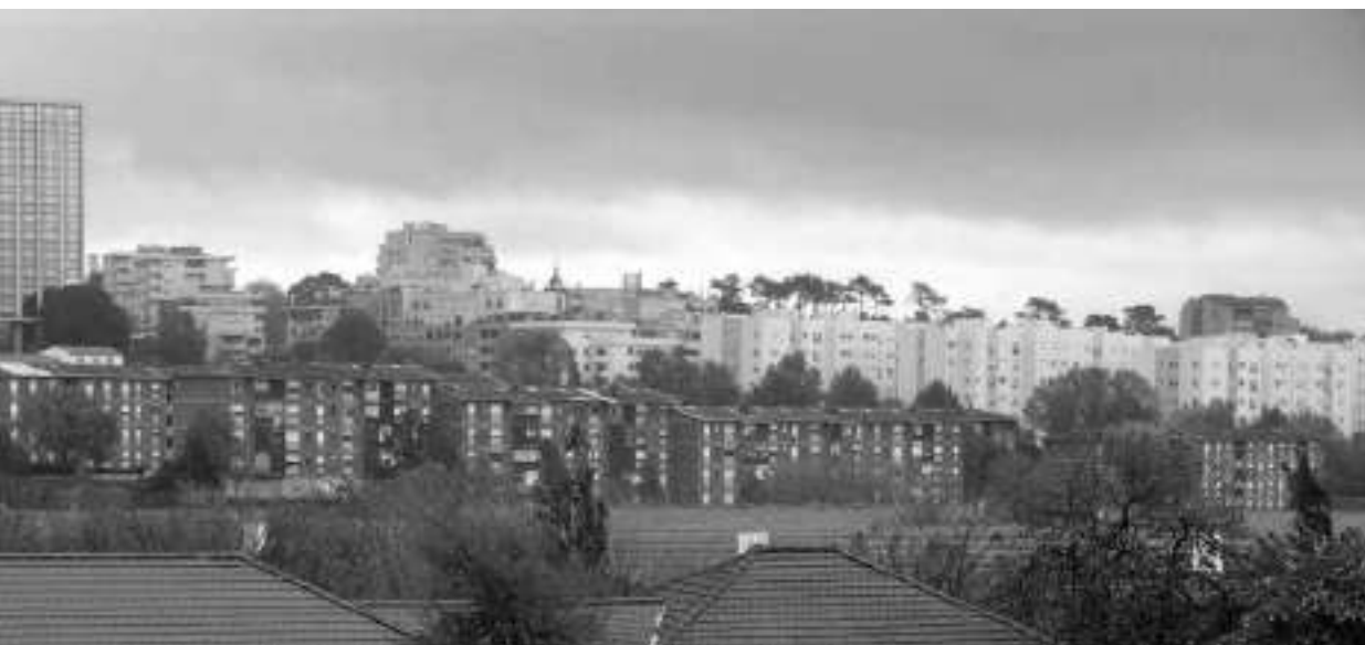
Fig. 01. Vista geral antes da intervenção
