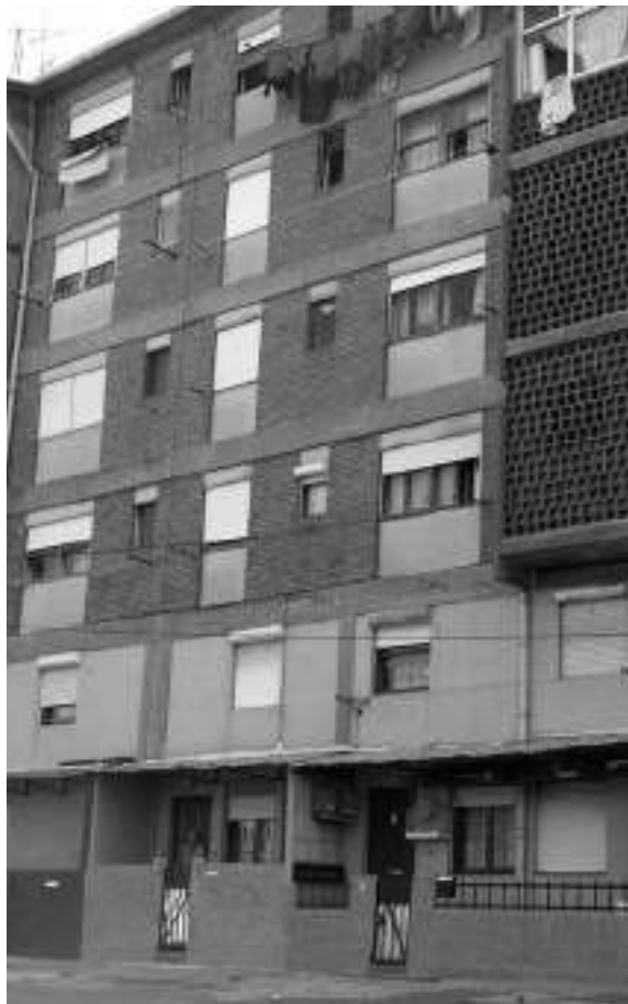
Fig. 07. Estado inicial - alçado posterior do bloco 15
