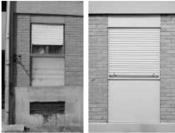
Fig. 17. Estores exteriores, antes e depois
