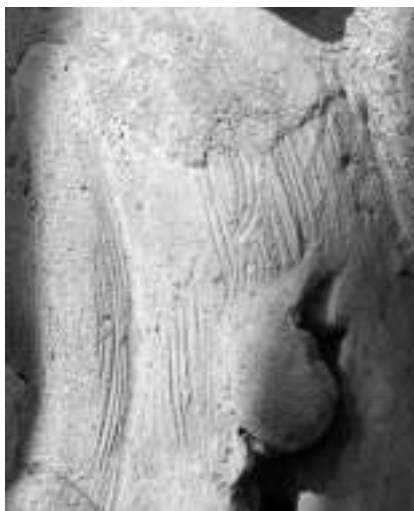
Fig. 24. Rasuras e emborro de proteção sobre elemento decorativo, 2014
