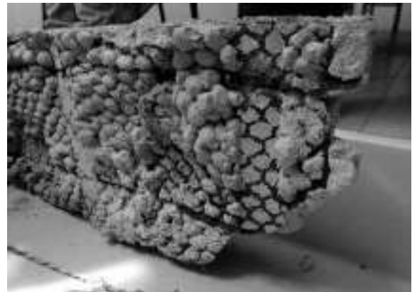
Fig. 04. Mísula original do TNSJ e processo construtivo em volume oculto com rede de galinheiro, varões metálicos e réguas de madeira, 2015
