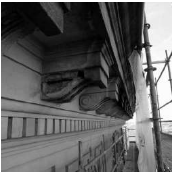
Fig. 29. Varões metálicos nas mísulas, 2013
