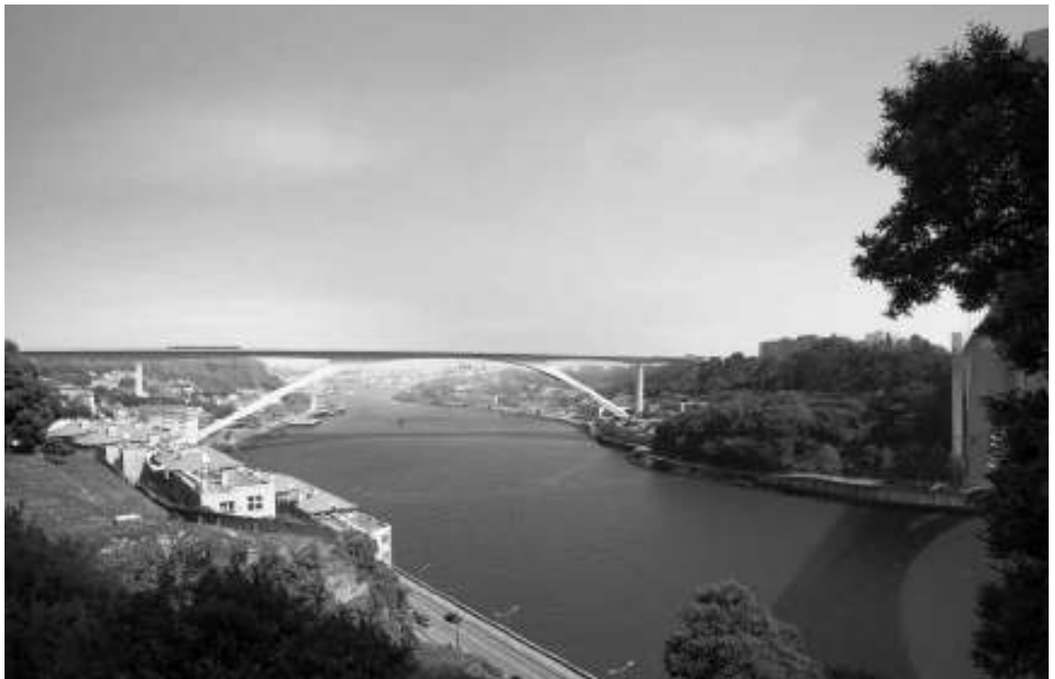
Fig. 06. A ponte de Arrábida
