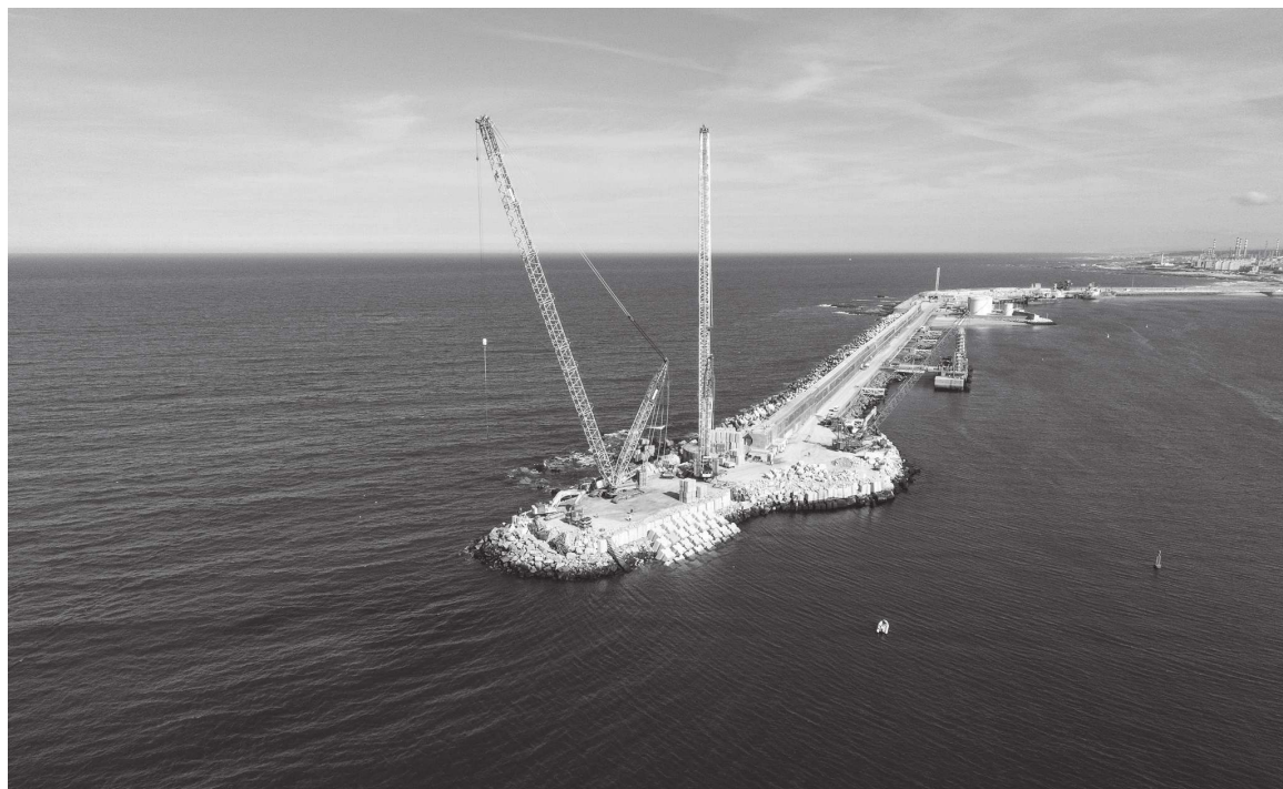
Fig. 09. Prolongamento do quebra-mar e proteção de Inverno
