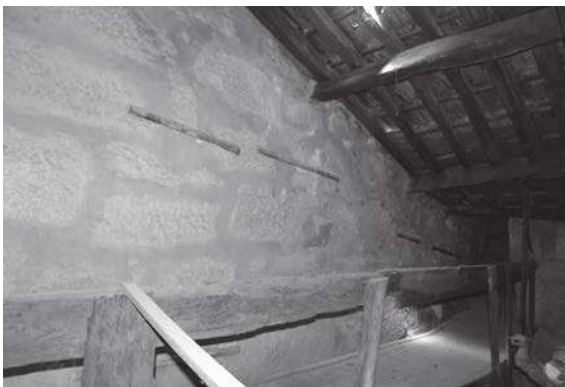
Fig. 06. Igreja dos Congregados - intervenções estruturais: agramos metálicos (a) na moldura da janela Este da fachada acima do piso do coro, (b) na parede do frontão da fachada (acima da abóbada) do lado Este, (c) na parede sobrejacente ao arco triunfal; (d) juntas refechadas no tímpano do lado Oeste
