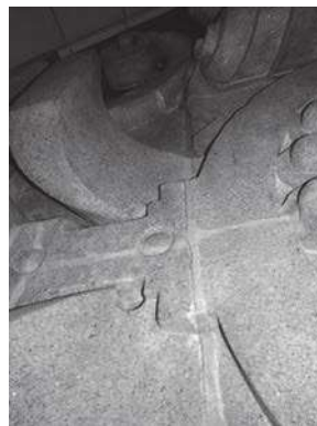
Fig. 06. Igreja dos Congregados - intervenções estruturais: agramos metálicos (a) na moldura da janela Este da fachada acima do piso do coro, (b) na parede do frontão da fachada (acima da abóbada) do lado Este, (c) na parede sobrejacente ao arco triunfal; (d) juntas refechadas no tímpano do lado Oeste
