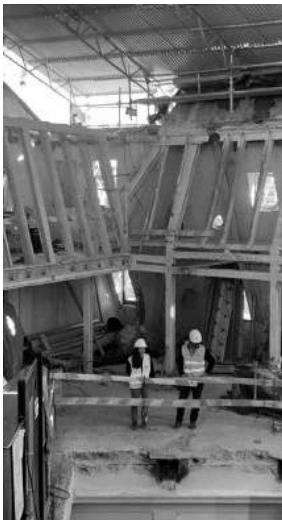
Fotografias da cobertura
