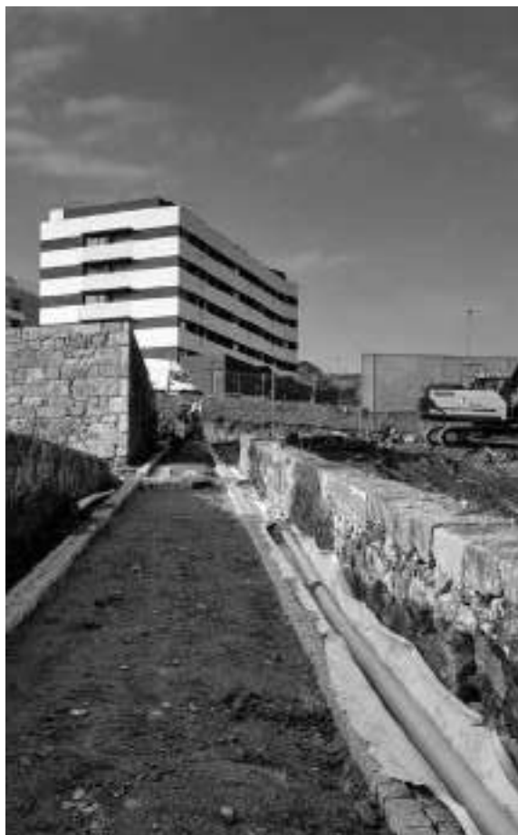
Fig. 41. Execução de guias em dupla fiada de paralelepípedo de granito colocado ao alto.
