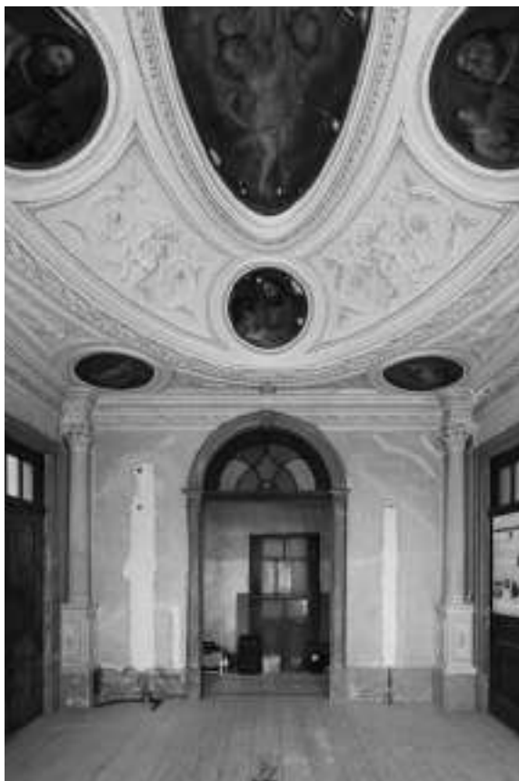
Antes da reabilitação - Capela.
