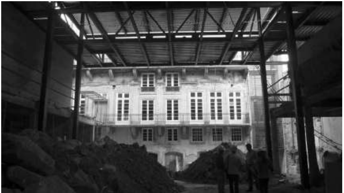
Sala-Estúdio em construção.
